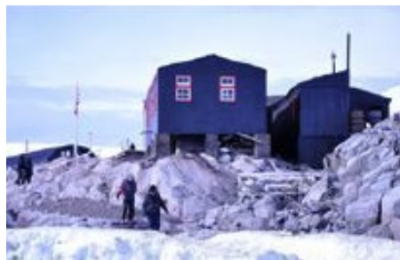
Foto. nr. 11 – Stația britanică Port Lockroy – vedere generală
